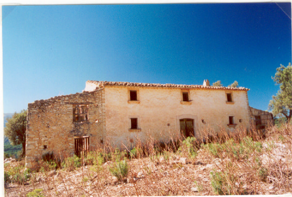
S'ULLASTRAR . FAÇANA PRINCIPAL
