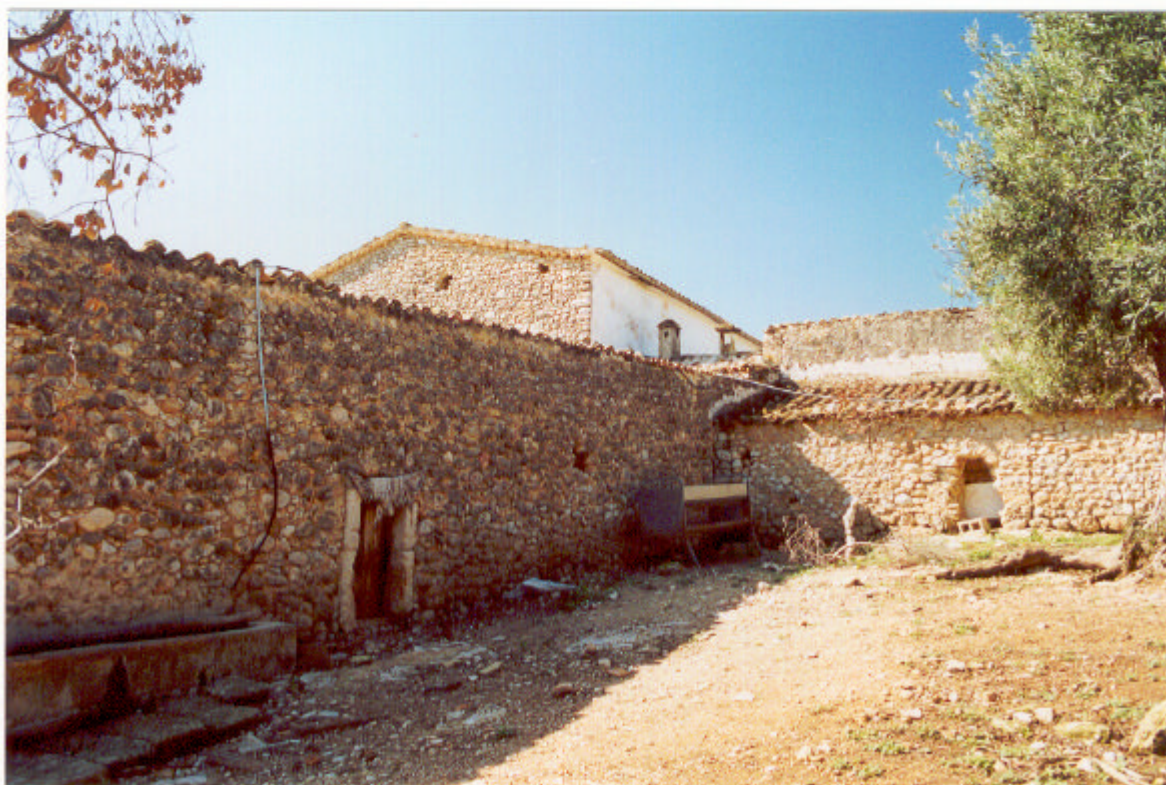
Son Borràs . Sostadors
