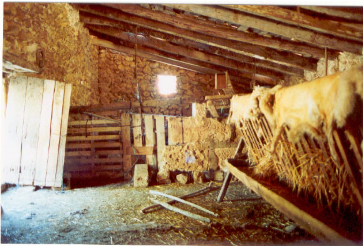
Son Borràs . Sostadors
