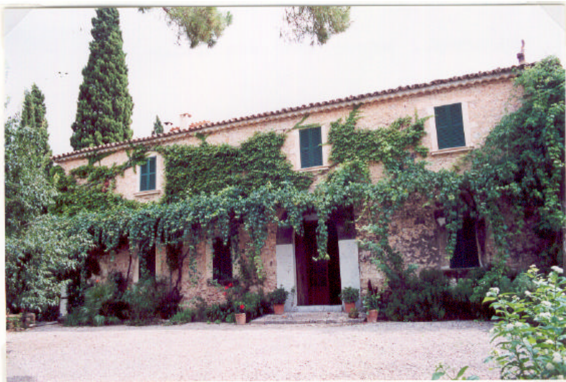
FANGAR . FAÇANA CASA DELS AMOS
