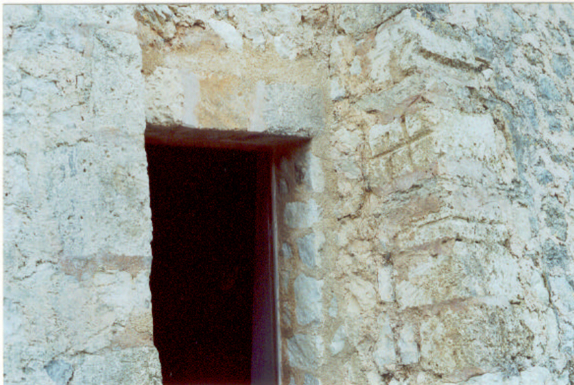
CASILLES GRAN. Portal entre safes (darrera)
