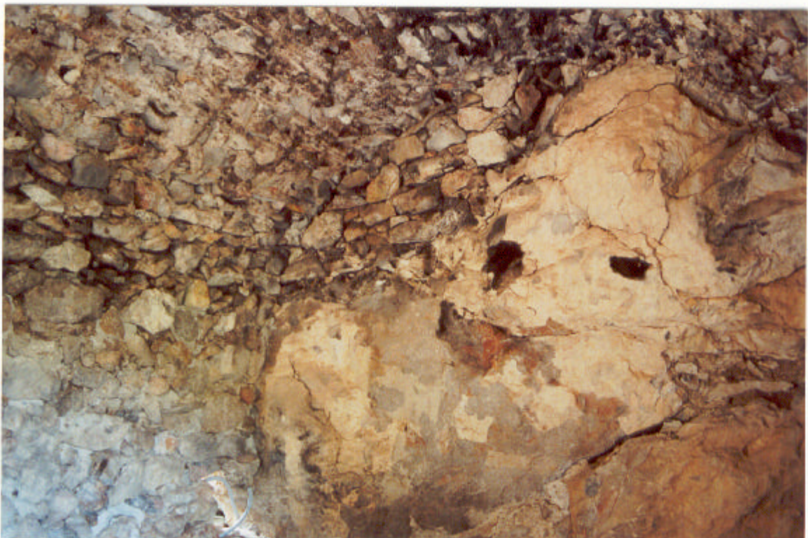
CASA DE SA TERRA (interior-volta)
