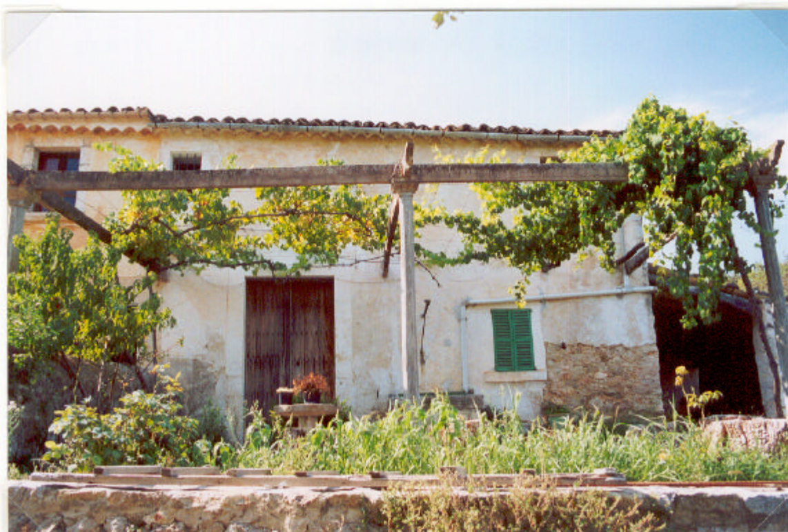
SON ROIG - CASA DE LA DRETA
