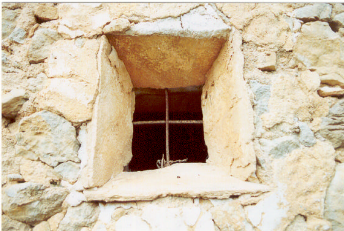
JA COVA . Finestroló (casa antiga)
