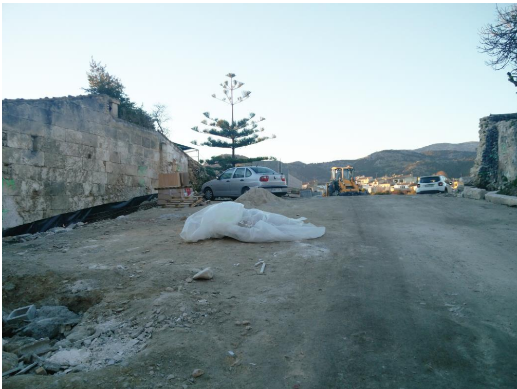
Fotografia 1. L'aparcament del carrer Major ja es troba en execució
